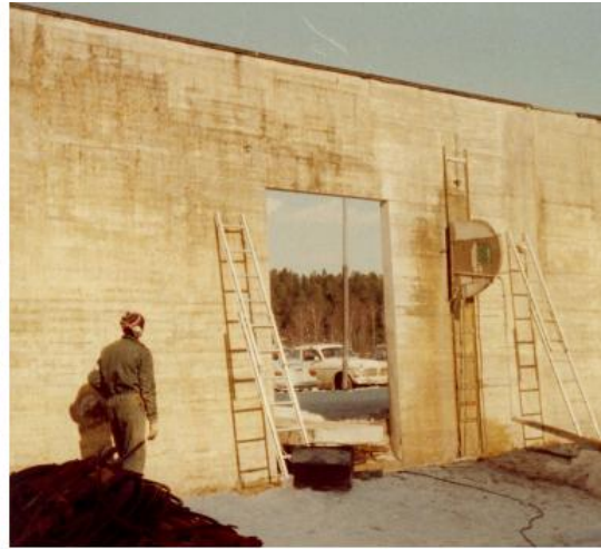
Sågning med Dimas väggsåg VS-10 "Järnhästen" på Hall kriminalvårdsanstalt.
